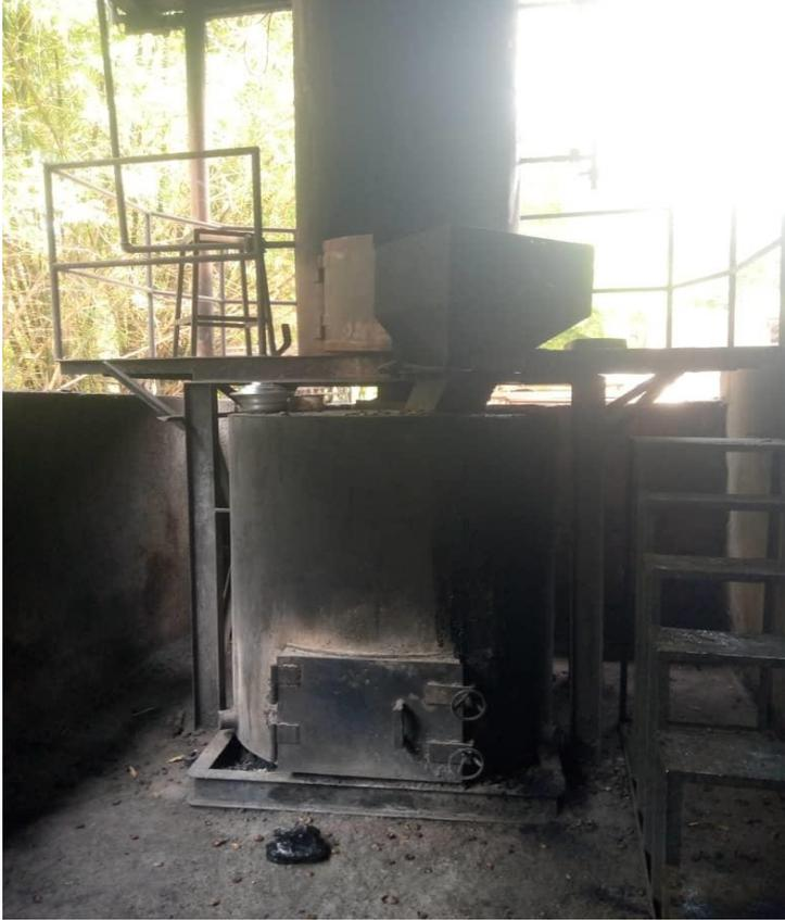
**Chaudière à pyrolyse H2CP (High Calorific Cashew Pyrolizer)**
