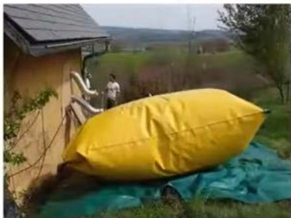
**Gazomètre de 6 m<sup>3</sup> (soit 6 jours d'autonomie assurée)**
